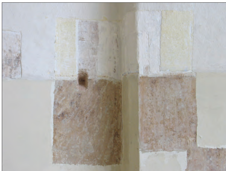
101. Schodiště z přízemí do patra v JV části ambitu, podesta, detail kletované omítky a barveného soklu
