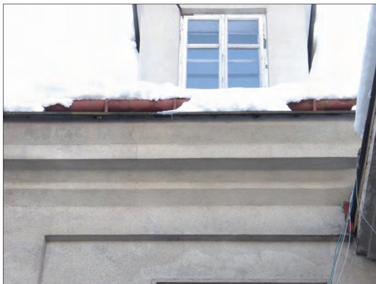
32. Detail zjednodušené korunní římsy na dvorním průčelí jižního křídla
