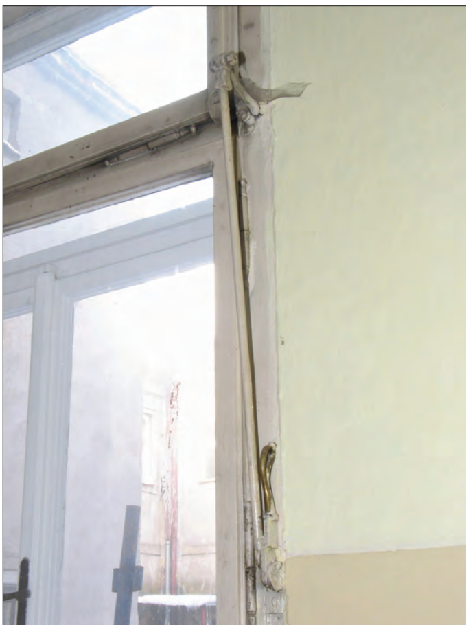
70. Detail pákového mechanismu otevírání větračky okna v jižní chodbě ambitu
