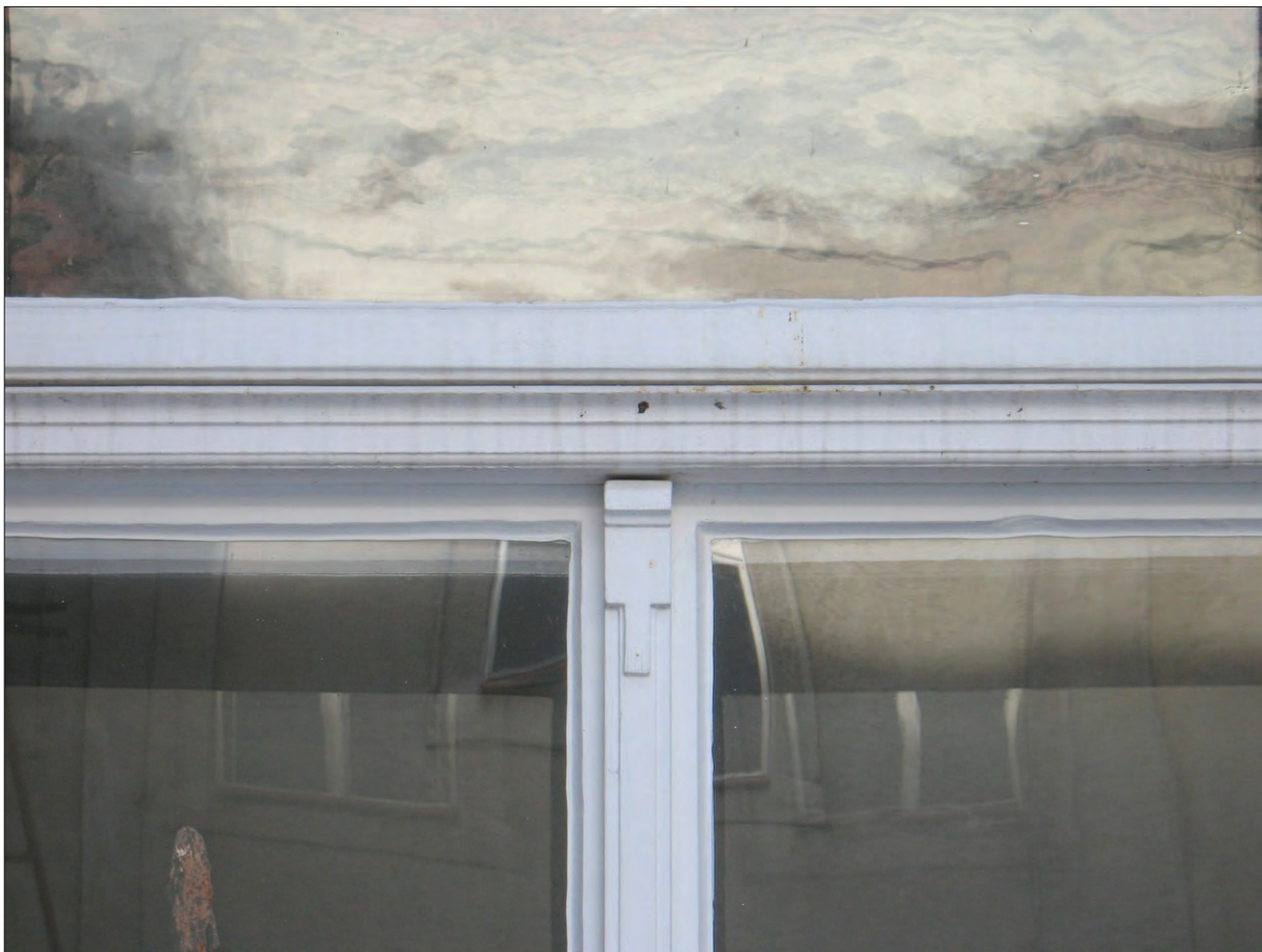
27. Detail profilace okenních rámců a klapačky na oknech ambitu
