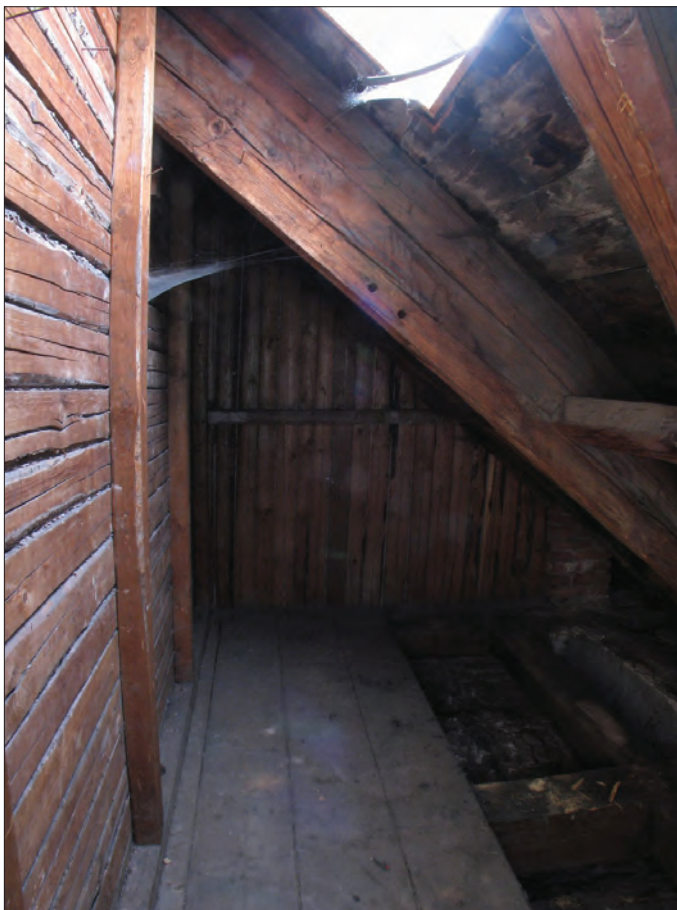
133. Podkroví v J křídle, detail řešení napojení jižní lehké stěny na krov
