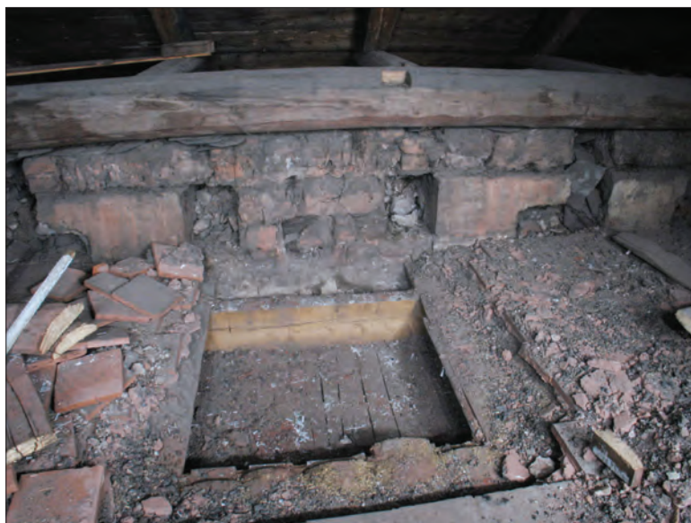
149. Krov Z křídla, severní část, pohled na pozůstatky původní koruny se zachovanými kletovanými omítkami a kapsami po stropních trámech, nad třetí místností od S, detail se skladbou záklopu
