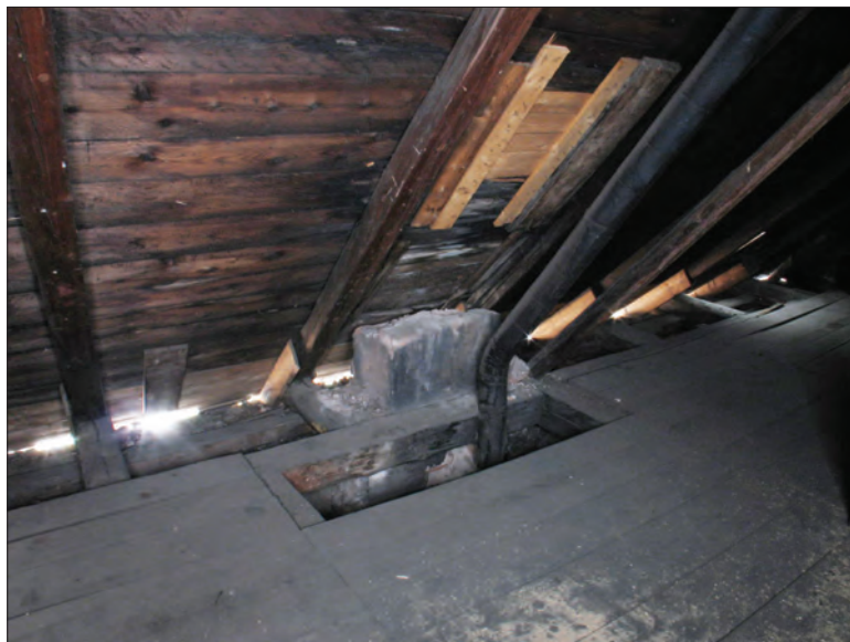
143. Krov nad refektářovým křídlem, pohled na pozů- statek zbořeného komínu na J straně
