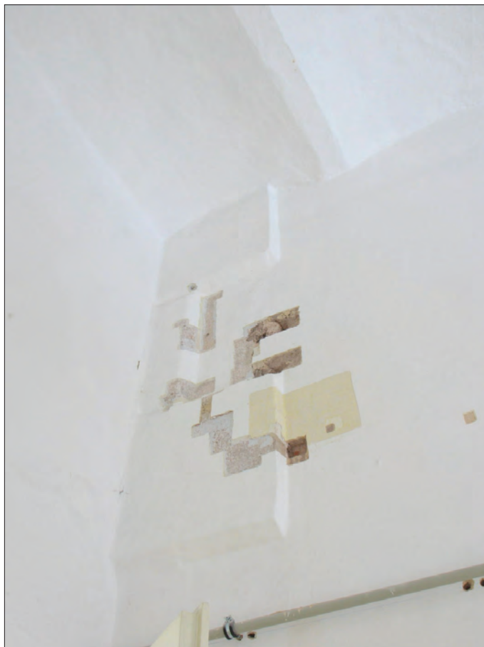
46. Pohled na pozůstatek nárožní bosáže v přízemí SZ přístavku
