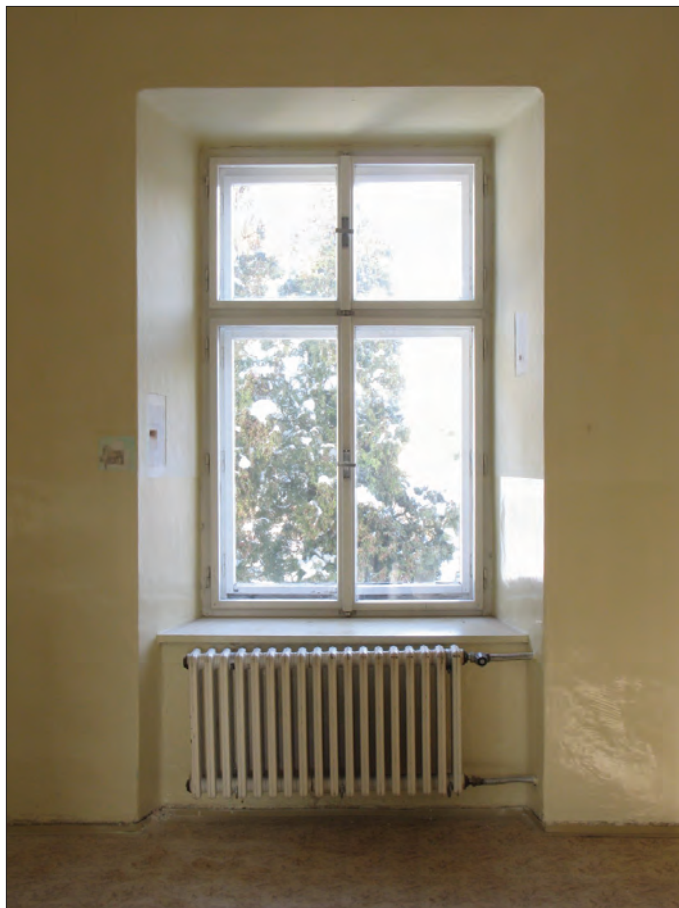
122. První patro, Z křídlo, detail okna s přímým záklenkem
