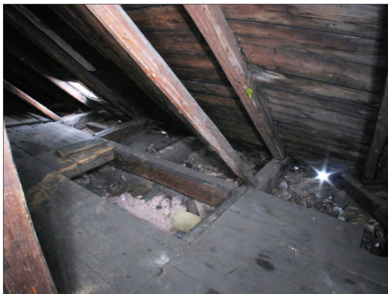
141. Krov nad refektářovým křídlem, pohled na prahovou část plné vazby
