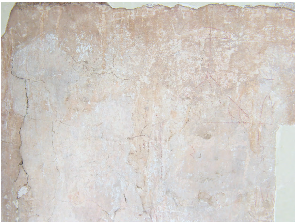
126. První patro, J křídlo, schodiště do podkrovní v JV části, podesta, detail kletované omítky na Z stěně, kresba rudkou
