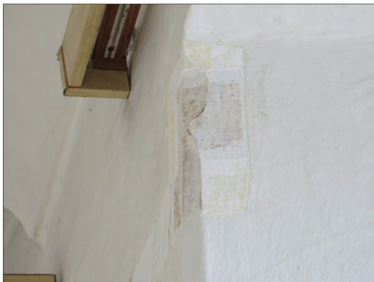
102. Schodiště z přízemí do patra v JV části ambitu, podesta, detail probrané hrany okenní špalety
